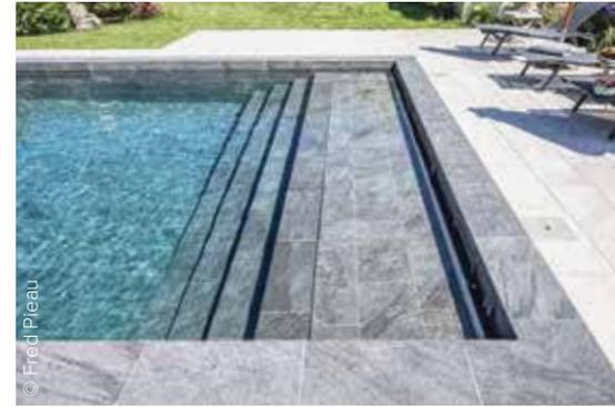
**Pour sécuriser le bassin, une couverture automatique immergée Rollinside de DEL a été installée sous la première marche du bassin. Ce volet immergé permet la création d'une banquette avant d'accéder à la piscine par des marches d'escaliers.**
